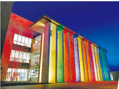
「十七条憲法」にちなんで庁舎の柱の数は17本。柱と柱の間に加え、建物の隣に立つアオダモの木も照らして17色に。
