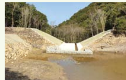
▲堤体を開削して利用廃止した虎熊池(洲本市)
