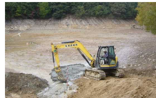
(ため池の浚渫工事)
