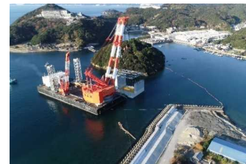
福良港 湾口防波堤
