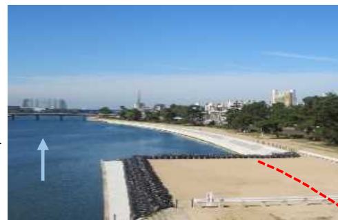
武庫川の河川改修 (赤点線：改修後の護岸の位置)
