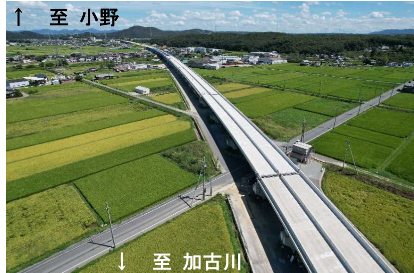
下村高架橋（加古川市）
