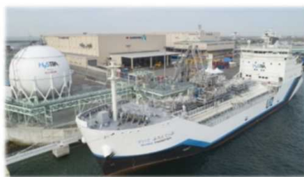
液化水素運搬船、液化水素タンク
