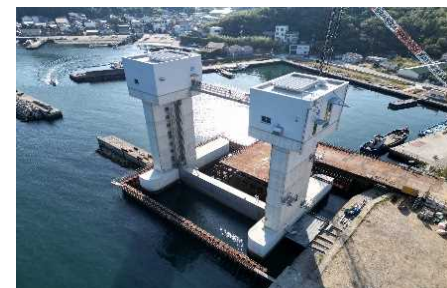
沼島漁港 水門整備
