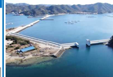
福良港 湾口防波堤 19
