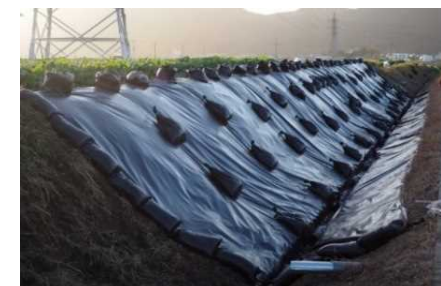
100%遮光シートを設置
