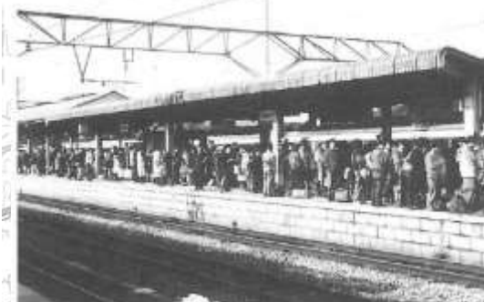
震災後の和田山駅の状況
