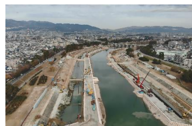
【武庫川護岸工事】
