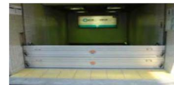
地下鉄出入口の浸水対策
