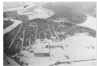
26日夜11時ごろ水防団が堤防破堤を防ぐべく必死の努力を行っていたが、円山川の支流の奈佐川が決壊した。あふれだした濁流は国鉄山陰線を越えてさか上り豊岡市内に大量に流れ込んだ。
