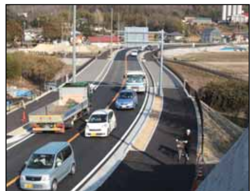
整備の事例(バイパス整備) (国)176号広野バイパス(三田市)
