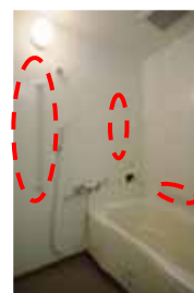
段差解消・手摺設置
