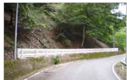
簡易な防災対策：小規模落石対策
