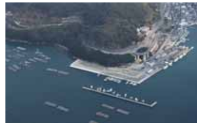
漁港整備(室津漁港:たつの市)
