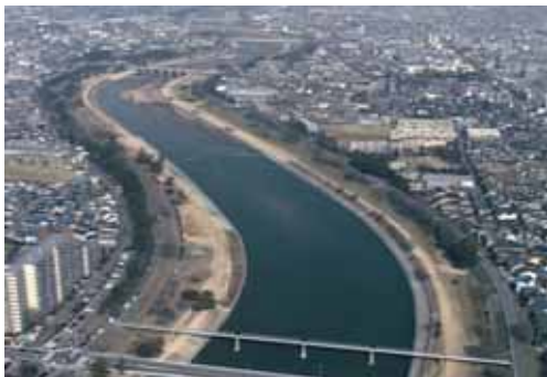
河川改修(武庫川)
