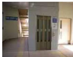
鉄道駅舎へのエレベーター設置
