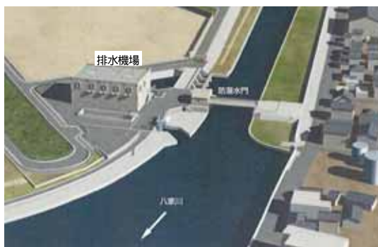
排水機場・水門整備(八家川:姫路市)
