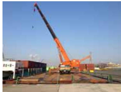
東播磨港 クレーン社会実験(高砂市)
