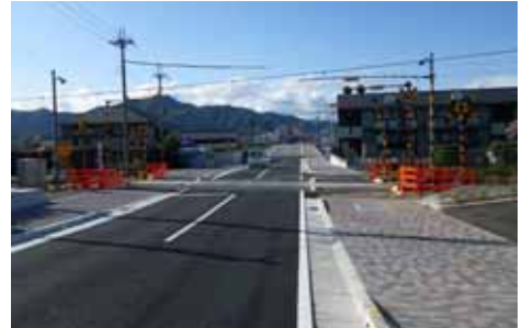
問題踏切の解消：安全な歩行空間の確保 (都市計画道路和布郷瀬線 和布第1踏切：西脇市)
