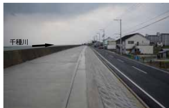
防潮堤整備(千種川:赤穂市)
