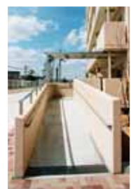
スロープ設置
