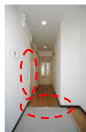
段差解消・手摺設置
