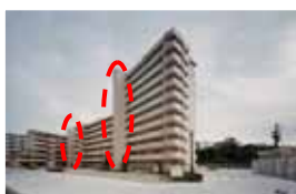
3階建以上EV設置
