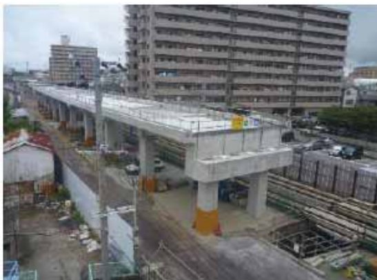
山陽電鉄西新町駅付近(明石市)
