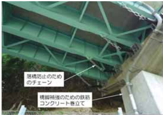
対震補強の事例：地震動でも落橋させない対策
