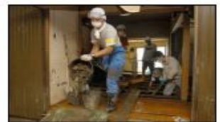
家壁の泥出し作業
