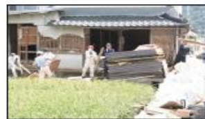
量などの搬出作業
