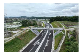
東播磨道北工区開通状況
