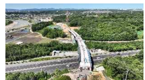
東播磨道北工区整備状況
