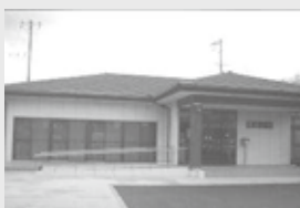
加古川市米田会館
