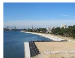
治水対策の推進（河川改修）
