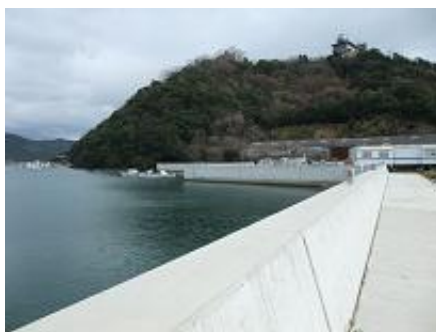
【防潮堤整備（福良港）】
