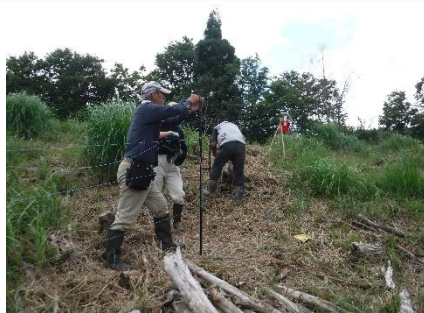
シカ柵の設置
