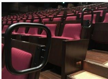
阪急中ホール座席の手すり設置
