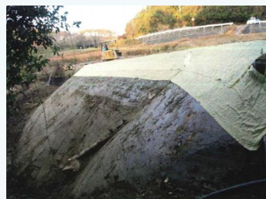
地藏堂下池の改修事業(淡路市)
