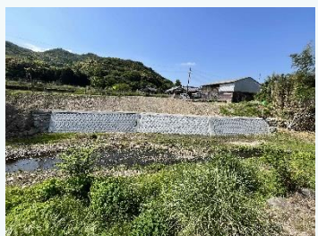
河川護岸改修事業(南あわじ市)
