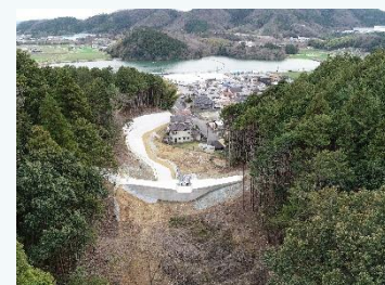
砂防堰堤の整備（兵庫県）
