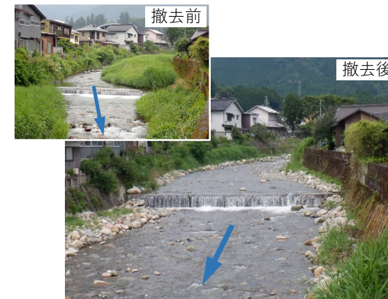
岩野辺川 堆積土砂撤去（宍粟市）
