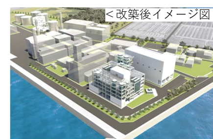
兵庫東流域下水污泥広域処理場(尼崎市)
