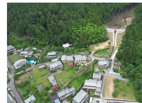
古瀬畑川 砂防堰堤 (姫路市)
