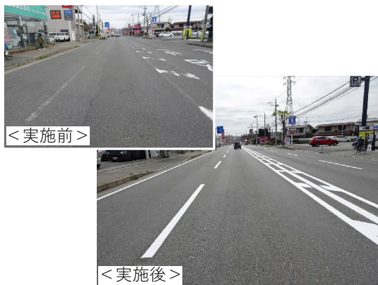
道路区画線の引き直し
