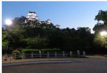
シロトピア記念公園の照明LED化 (姫路市)
