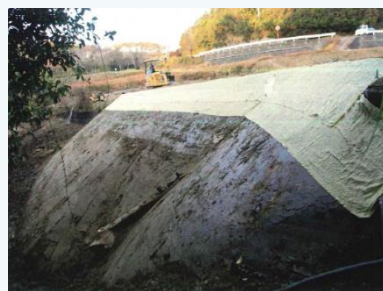
地藏堂下池の改修事業(淡路市)
