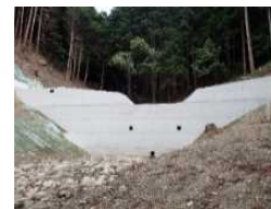
治山ダムの整備
