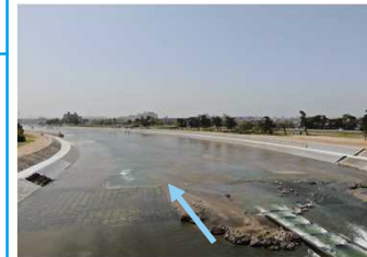
武庫川 河川改修
