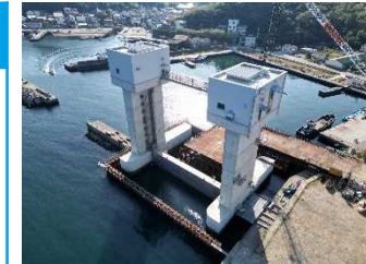
沼島漁港 水門整備
