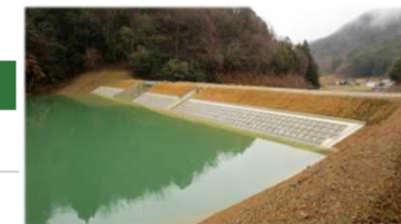
ため池等整備事業 (倉谷池地区)
