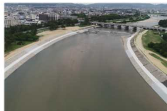
武庫川 護岸工事(尼崎市・西宮市)
