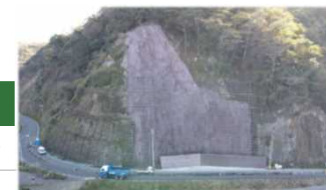
国道178号(新温泉町)
