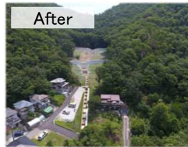
治山ダムの整備 (三田市上青野地区)
