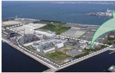
兵庫東流域下水汚泥広域処理場
