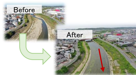
明石川(神戸市) 堆積土砂撤去
