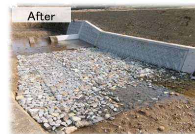
島谷川の改修 (通水断面の確保・河床の洗堀防止等)
