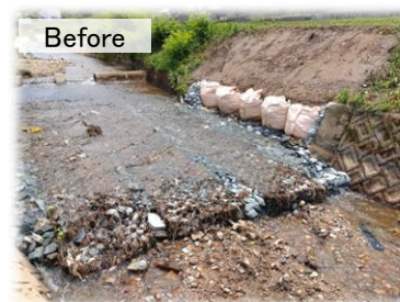
島谷川の改修 (通水断面の確保・河床の洗堀防止等)
