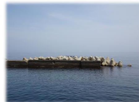
釜屋漁港北防波堤の改良
