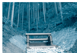
簡易流木止め施設
