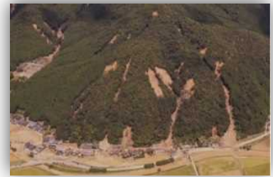
H26 山腹崩壊(丹波市)
