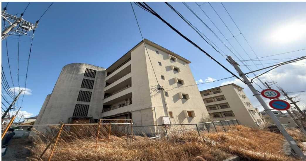
② 全体図(西側より)
