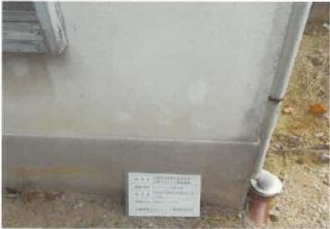
■ No.1 試料採取場所の補修後
