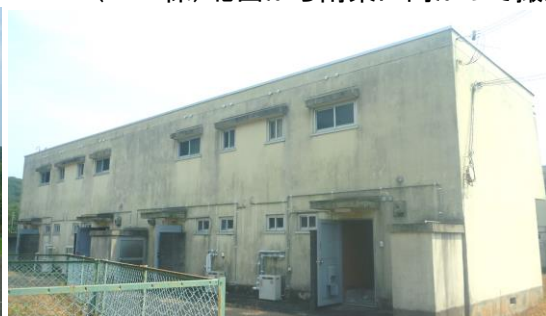
(A-2棟)北西から南東に向かって撮影
