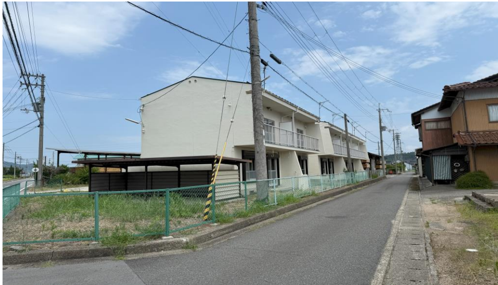
② 全体図(東方より)
