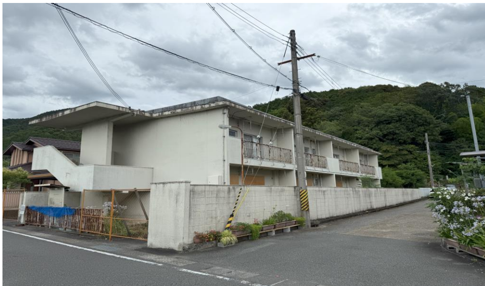
② 全体図(北西方より)
