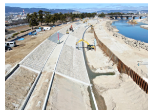
武庫川(西宮市・尼崎市) [河道拡幅]
