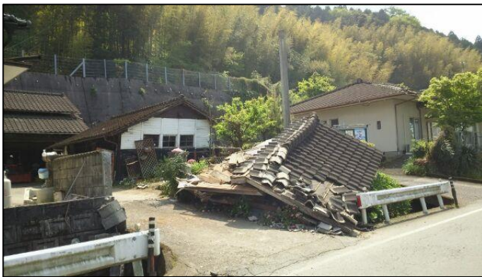
倒壊した家屋（大津町）
