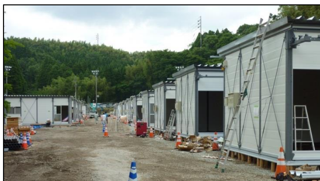
仮設住宅建設現場
