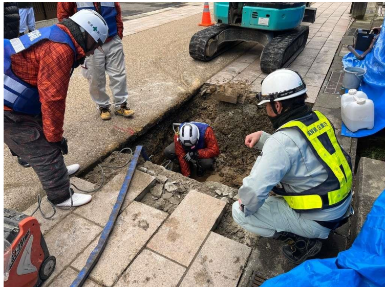
上水道復旧支援(能登町内)
