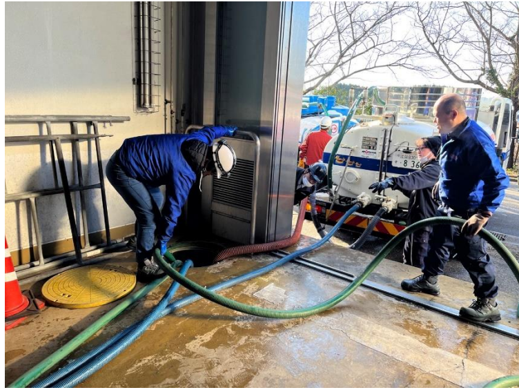
稼働停止中の施設のし尿回収作業の状況
