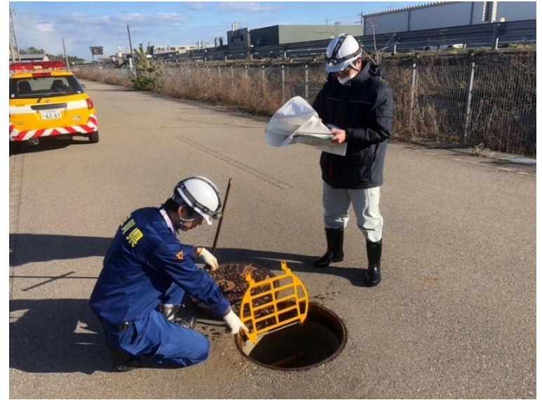
下水道管渠被害調査の様子
