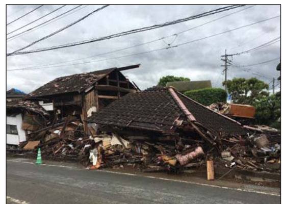
地震による家屋の倒壊 (平成28年熊本地震)
