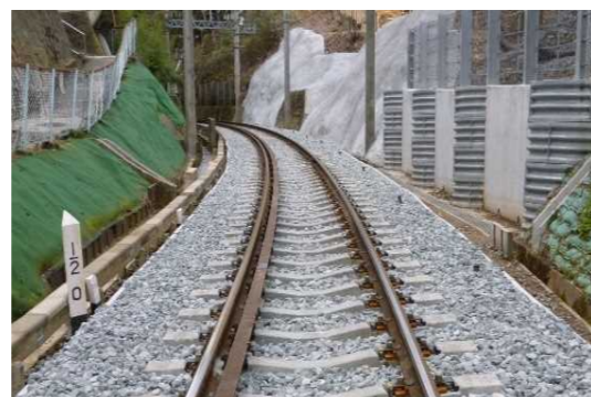
【神戸電鉄の法面防護工事】
