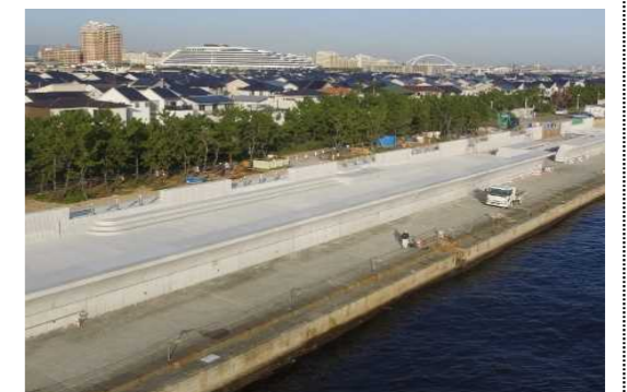
【防潮堤の嵩上げ(南芦屋浜地区)】
