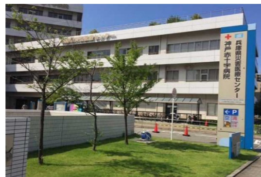
【非常用電源整備済みの兵庫県災害医療センター(重要施設)】
