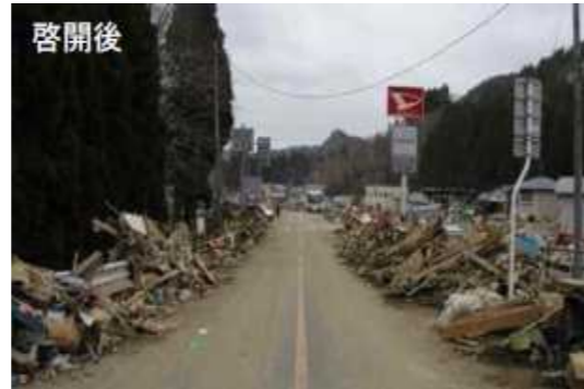
【道路啓開状況 (岩手県宮古市田老地区)】 出典：震災伝承館 (東北地方整備局 HP)
