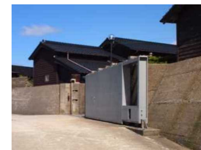
【陸閘(香美町無南垣)】
