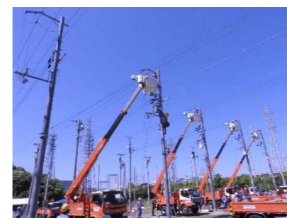
【関西電力(株)の訓練の様子①】
