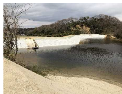
【清水谷池(神戸市西区押部谷町)】
