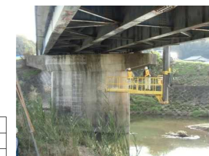
【橋梁下面の点検の様子】
