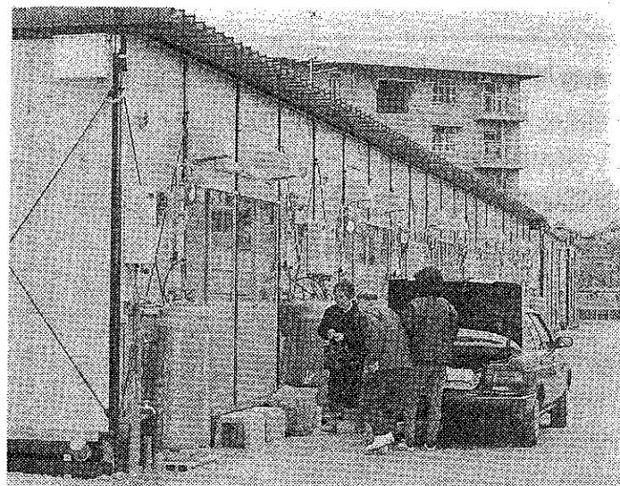
入居が始まった仮設住宅(伊丹市)
