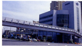
国道2号を横断するエレベータの整備された歩道橋。
