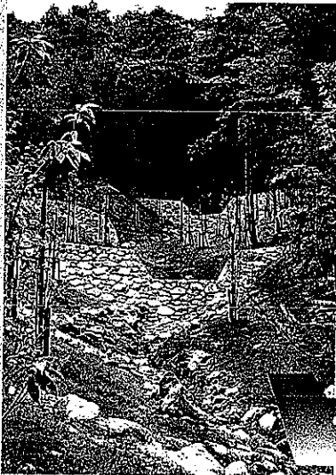
北区湯谷川の堰堤
