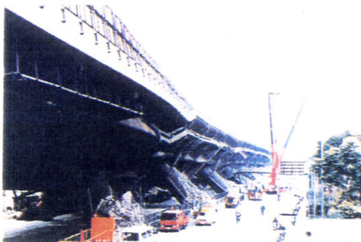
▲ 倒壊した阪神高速道路神戸線
