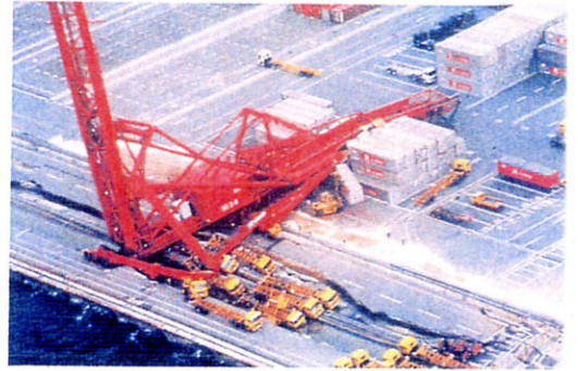
▲ 倒壊したガントリークレーン（ポートアイランド）
