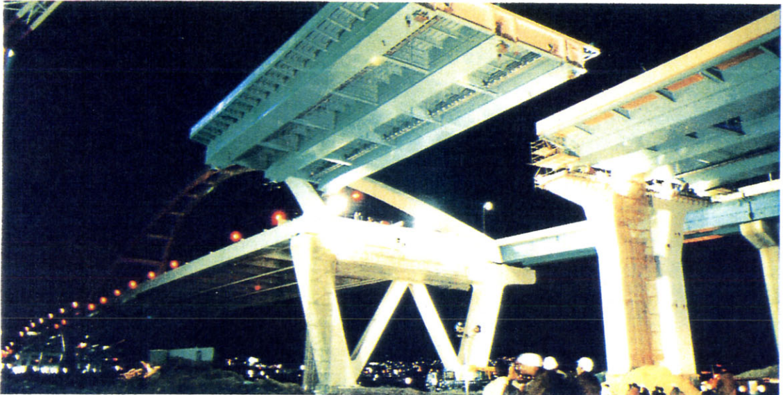
▲ 復旧の進む阪神高速道路大阪湾岸線（西宮港大橋）
