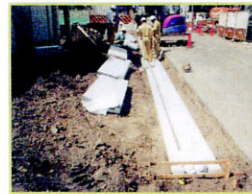
■清水町工事着手
