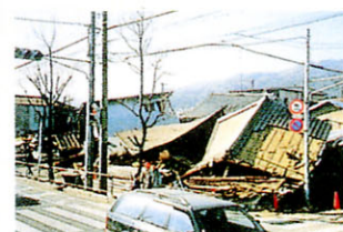
地区の被災状況
