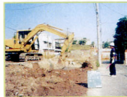
■前田町工事着手
