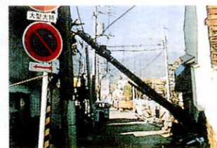
地区の被災状況
