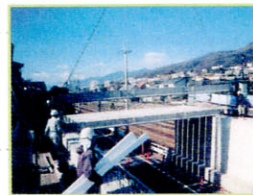
■白橋の整備工事
