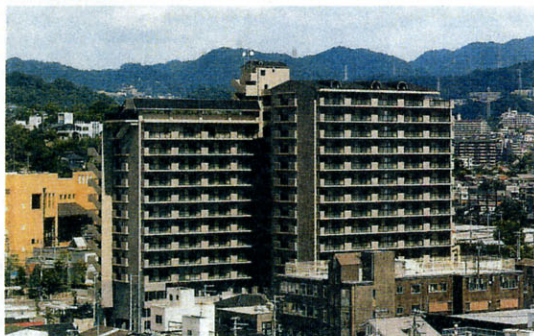
新長田駅北地区／共同化住宅「東急ドエル・アルス 御屋敷通」（99戸）
