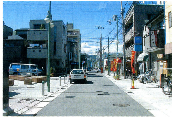
地区中央に整備された南北のコミュニティ道路（幅員10m）
