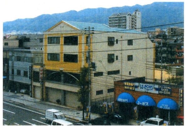
再建された建物の状況
