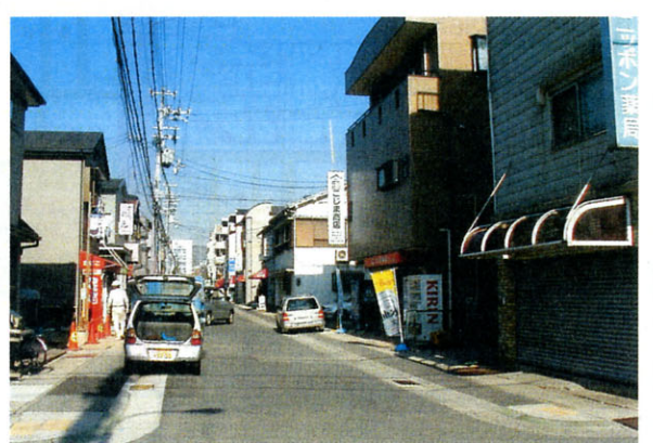
整備された区画道路（幅員8m）
