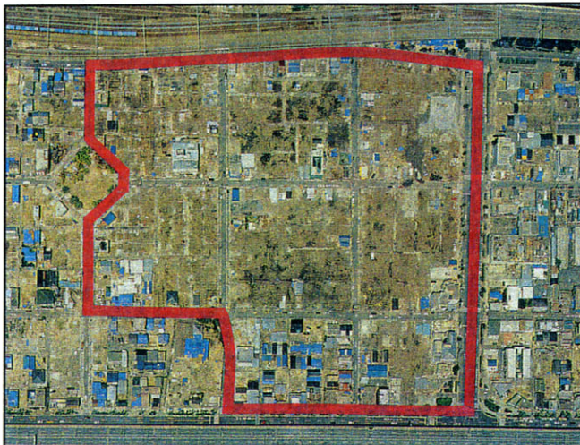
震災後 平成7年5月
