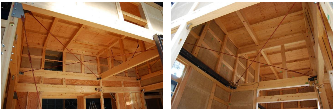
図4 2階床面補強のための水平筋交い
