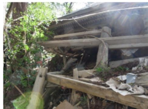
柱・壁状況：継手・仕口が折損、要修理
