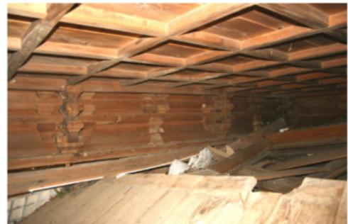
左側面室内：台輪から上部形状保持、天井も残る、小屋組も健全か、床材残る
