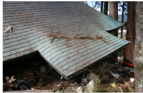
正面向拝：津波により完全に倒壊、向拝柱四散
