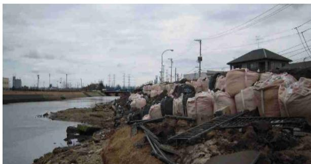
大型土嚢による河川堤防の補強（多賀城市）
