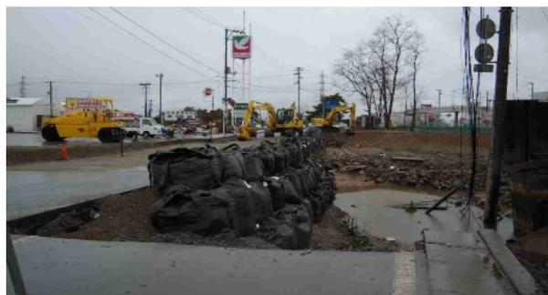
大型土嚢による道路崩壊の防止（石巻市）
