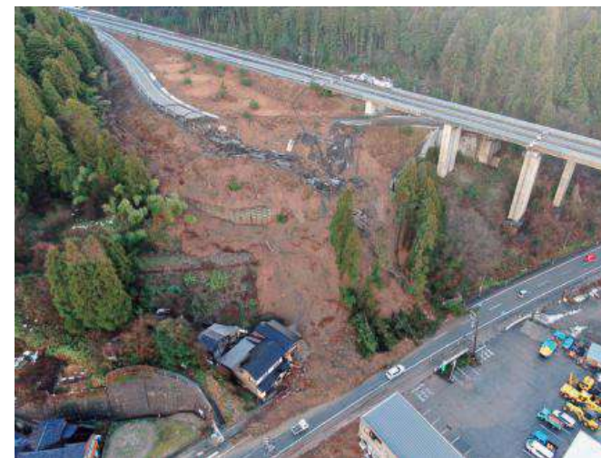
盛土部が崩落した能越自動車道（穴水町） 出典：国土交通省
