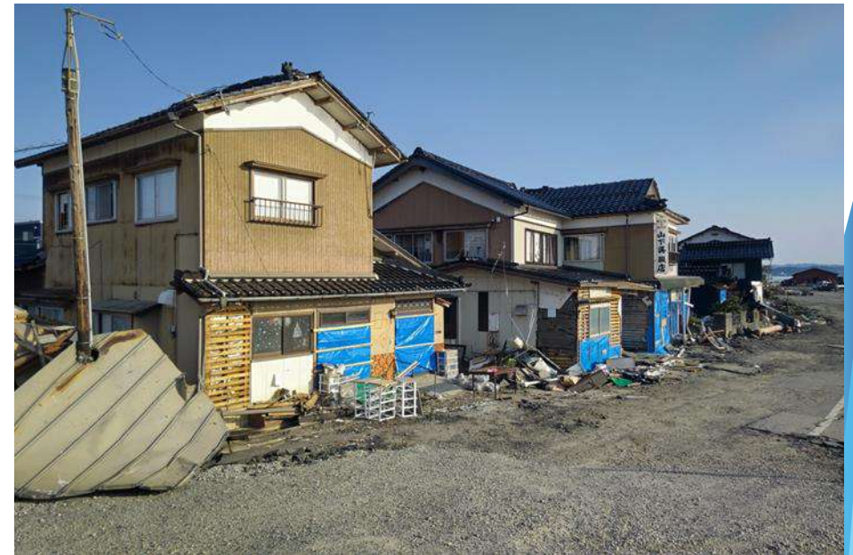
珠洲市宝立町鵜飼地区の津波被害
