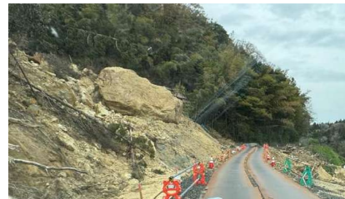
道路の仮復旧状況（珠洲市内）
