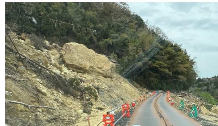
道路の仮復旧状況（珠洲市内）
