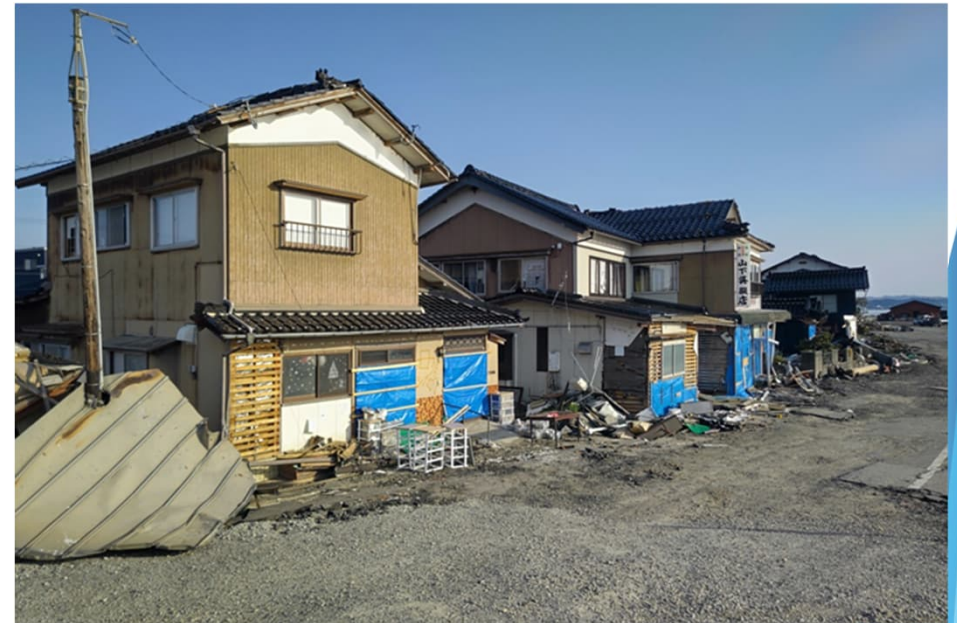
珠洲市宝立町鵜飼地区の津波被害
