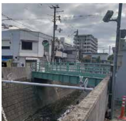
▶ 河川監視カメラ
