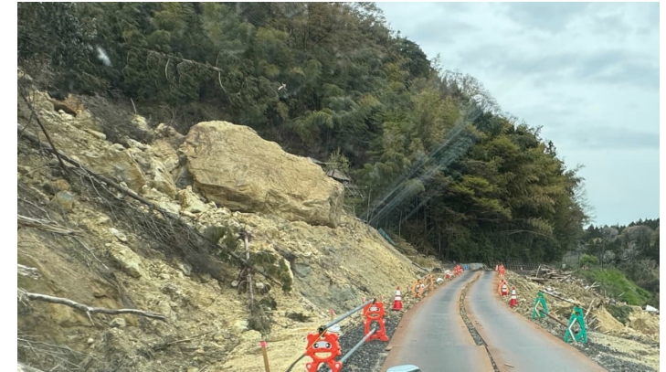
道路の仮復旧状況（珠洲市内）
