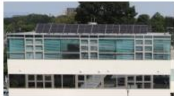
再生可能エネルギー (太陽光) 設備
