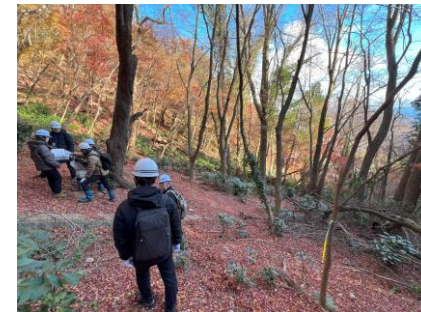
▲自然と一体化しつつある治山施設
