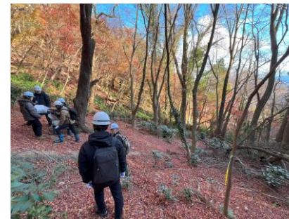
▲自然と一体化しつつある治山施設
