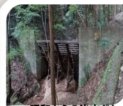
昭和からの治山ダム
